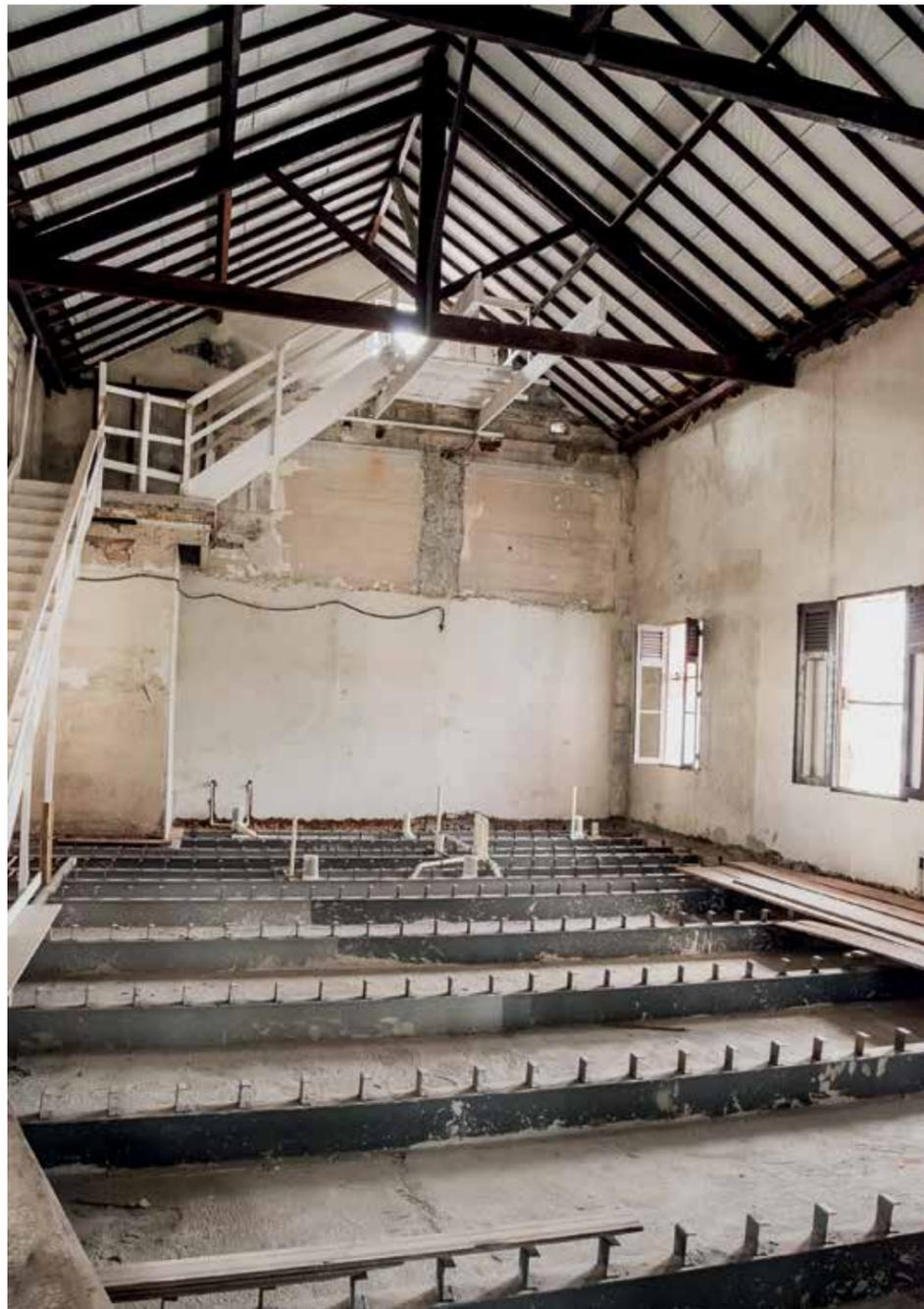
Vista do madeiramento do telhado recuperado e estrutura das lajes.
