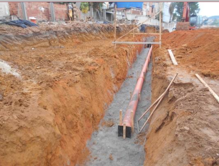
Rede de esgoto – Rocha Miranda / RJ
