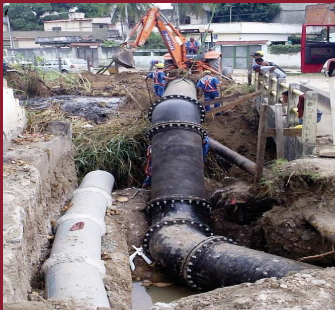
Adutora – São Gonçalo/RJ
