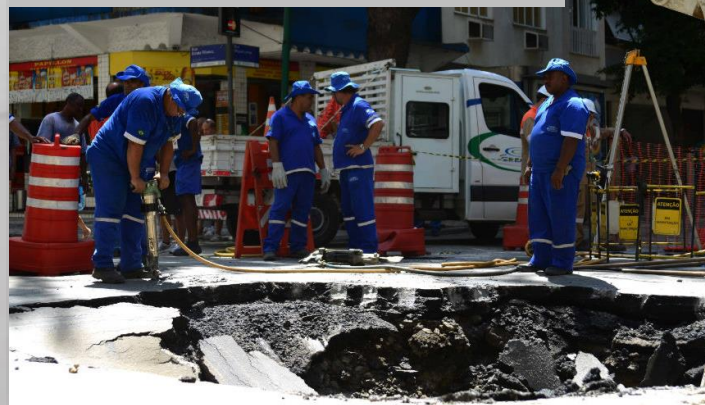
Reparo Copacabana – Rio de Janeiro
