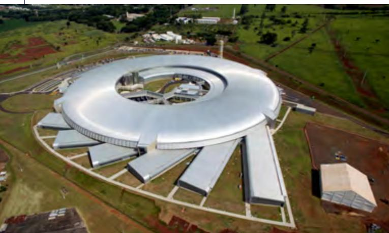
O formato predominantemente circular do edifício do Sirius, com raio externo de aproximadamente 120 m, é resultado da geometria dos aceleradores de partículas, onde os elétrons são armazenados e a luz síncrotron é produzida. No interior desta edificação foi implantada a blindagem dos aceleradores.
