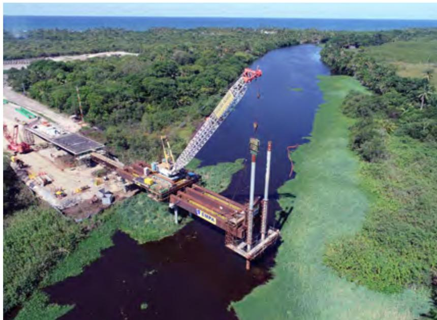
inovadora, dimensionada exclusivamente para este projeto. A obra foi executada com o auxílio de uma plataforma de apoio à cravação de estacas - cantitraveller, que funciona como estrutura provisória, composta de vigas metálicas (tipo caixão), plataforma de armazenamento e guia de cravação, sendo as estrutu-
